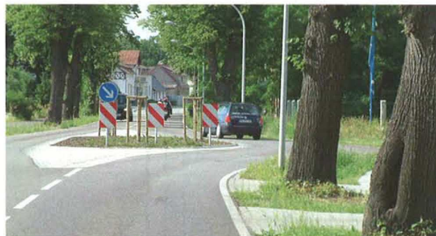
Geschwindigkeitsdämpfung im Ortseinfahrtbereich durch Mittelinsel mit deutlichem Fahrbahnversatz
